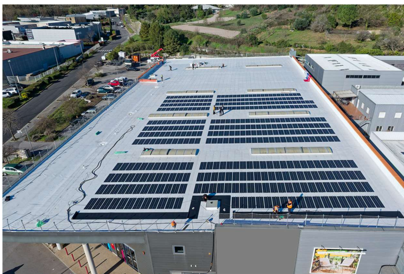
Exemple indicatif de mise en œuvre sur toiture-terrasse ayant bénéficié d'une rénovation d'étanchéité : 414 modules Stykon® 4X20M10, pour une puissance totale installée de 120 kWc
