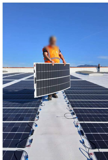
Exemple indicatif de mise en œuvre sur toiture-terrasse ayant bénéficié d'une rénovation d'étanchéité : 414 modules Stykon® 4X20M10, pour une puissance totale installée de 120 kWc
